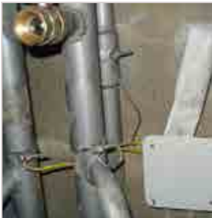
Заземление водоснабжения
