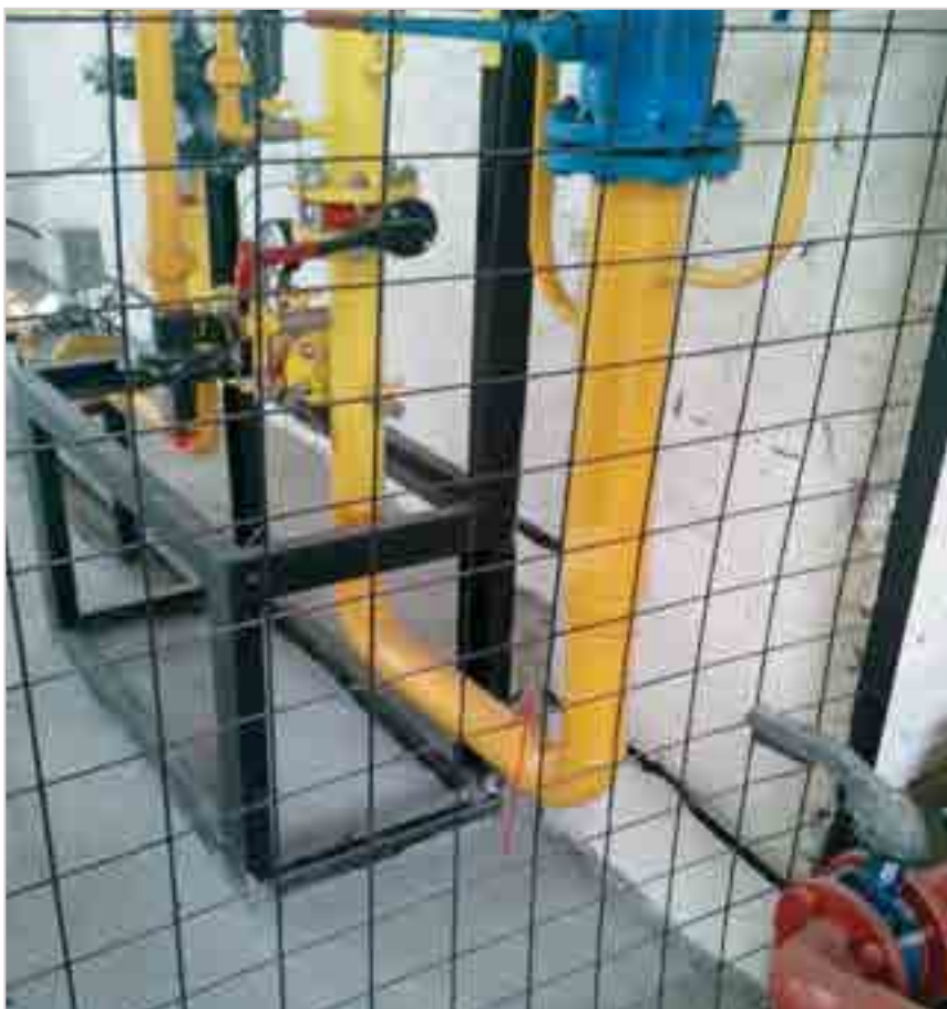
Заземление газопровода
