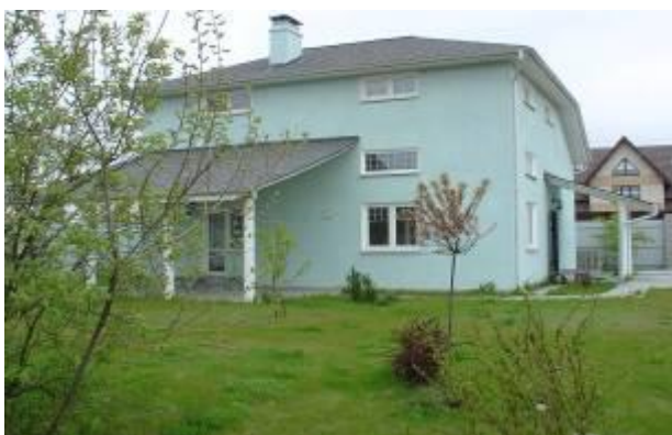
Рис. 4. Фотография коттеджа, на котором был смонтирован экспериментальный образец комбинированной системы
