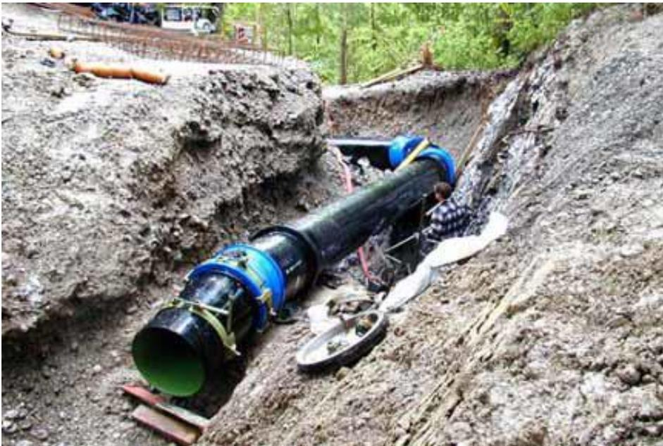
Рис. 1. Фото с объектов монтажа труб из ВЧШГ
