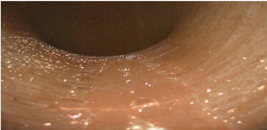
Рис. 3. Модифицированная поверхность трубы по МАК-технологии
