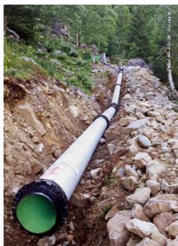
Рис. 4. Монтаж ВЧШГ-труб с полиуретановым покрытием
