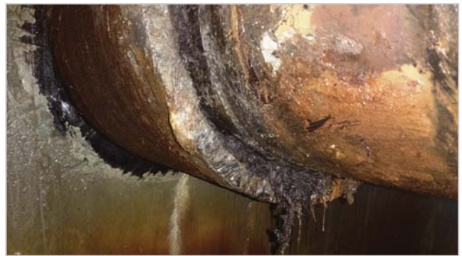
Рис. 3. Проход трубы теплоснабжения в гильзе через фундамент многоэтажного жилого комплекса. Протечка через зазор между внутренней поверхностью гильзы и рабочей трубой. Видны остатки каболки, внизу, под торцом гильзы, установлена бочка для сбора грунтовой воды, вытекающей из гильзы. Аналогичный вид имеет проход второй трубы теплоснабжения
