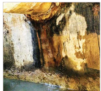
Рис. 3. Проход трубы теплоснабжения в гильзе через фундамент многоэтажного жилого комплекса. Протечка через зазор между внутренней поверхностью гильзы и рабочей трубой. Видны остатки каболки, внизу, под торцом гильзы, установлена бочка для сбора грунтовой воды, вытекающей из гильзы. Аналогичный вид имеет проход второй трубы теплоснабжения
