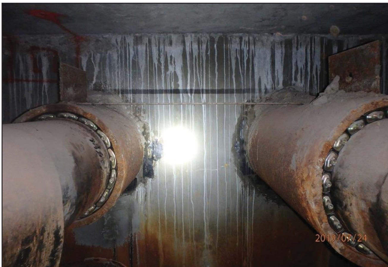
Рис. 17. Узлы герметизации АктивРинг приняты в эксплуатацию после испытаний
