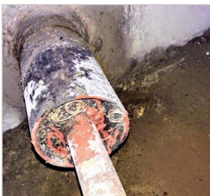
Рис. 2. Вид установленного узла герметизации
