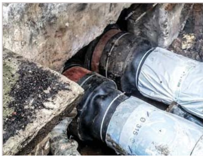
Рис. 16. Узлы герметизации АктивРинг* установлены в проход в фундаменте 9-этажного жилого дома для последующего бетонирования
