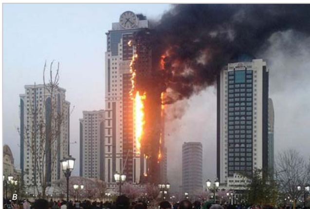
Рис. 5. Повреждение НФС многоквартирных жилых домов в результате пожара: а) г. Владивосток, ЖК «Атлантис» [17]; б) г. Москва, ул. Ивана Бабушкина [18]; в) г. Грозный, ЖК «Олимп» [19]; г) г. Красноярск, ул. Шахтеров [20]
