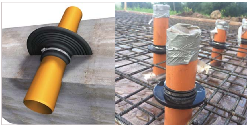
Рис. 13. Гидроизолирующий воротник
